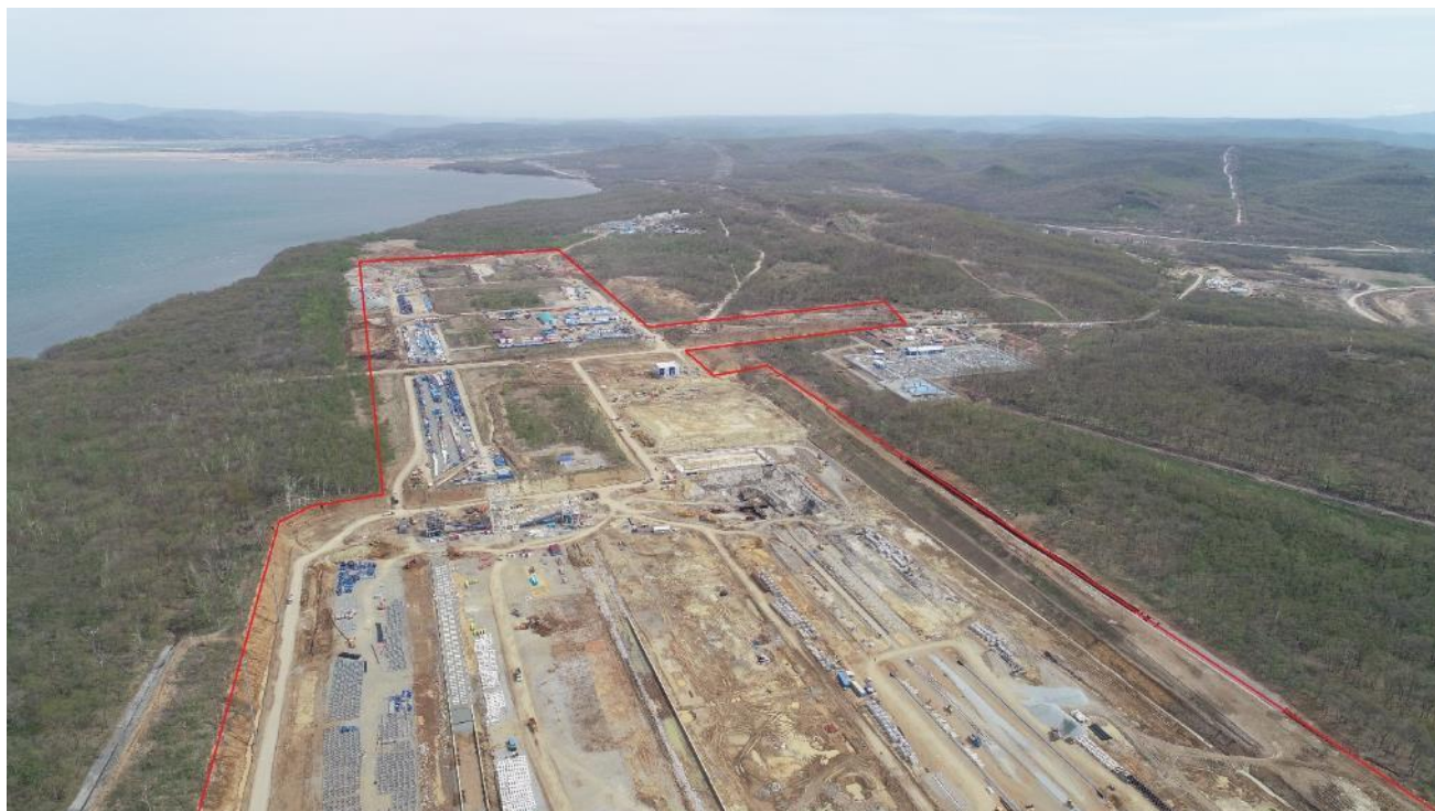
Рисунок 3.10 – Общий вид территории строительства
